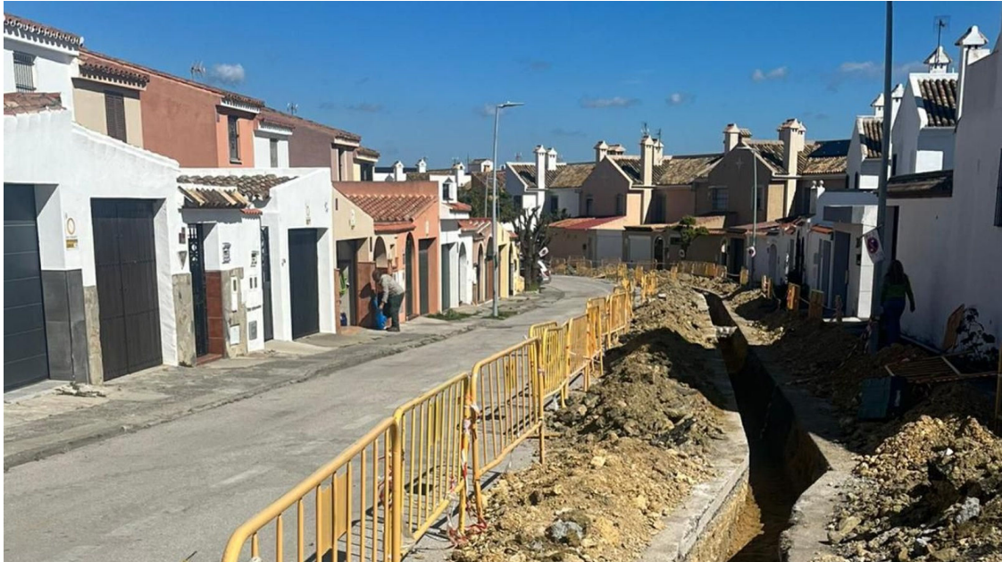
Obras en la red de abastecimiento en la calle Trucha.
